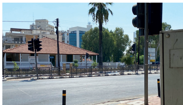
Νοέμβριος 2019: Σύνδεση του κεντρικού κτιρίου της Βουλής με το Σπίτι του Πολίτη με οπτικές ίνες και σημαντική αναβάθμιση της σύνδεσης διαδικτύου στην ανώτερη προσφερόμενη ταχύτητα του 1Gbps.
